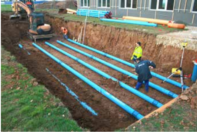
Plaatsing van de lucht-aardwarmtewisselaar in het REHAU verkoopkantoor te Metz
