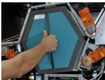
Figuur : tegenstroomwarmtewisselaar
