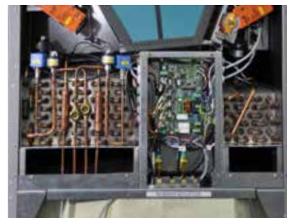
Figuur : warmtewisselaar en condensaatopvangbakken
