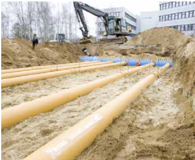
Aansluiting van de aardwarmtewisselaarbuizen AWADUKT Thermo met antibacteriële laag DN 250 op een geprefabriceerde verdelerbalk uit polypropyleen
